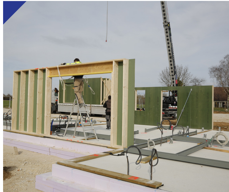
Pose de l'ossature bois par l'entreprise Wood Construction .
